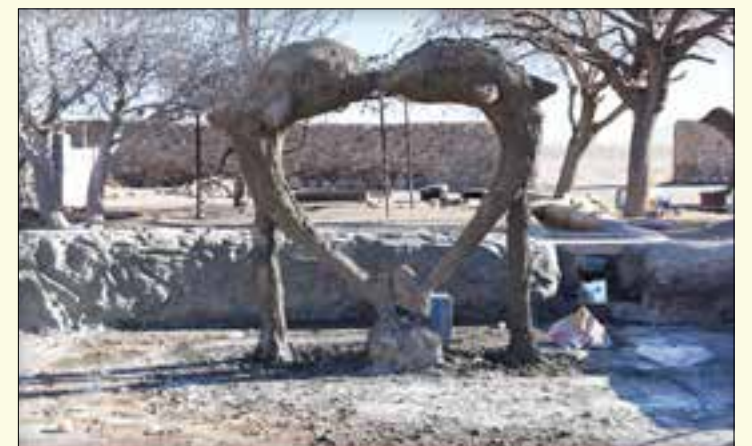
مرمت و بازسازی خانه بومگردی درویش خان
