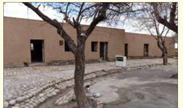
مرمت و بازسازی خانه بومگردی درویش خان
