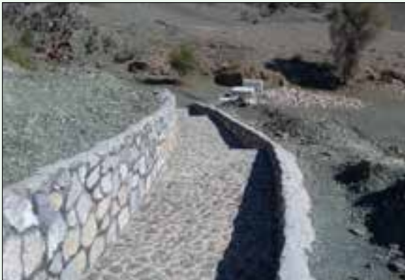
اجرای راه‌پله در کوه
